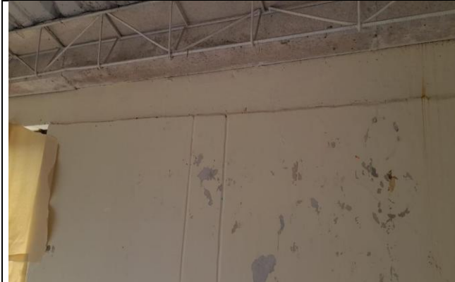
Foto 03: Pintura en mal estado.
