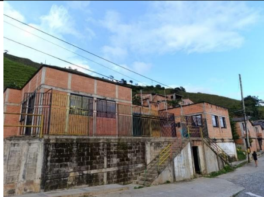
Foto 04: Fachada, escaleras e ingreso al CDI
